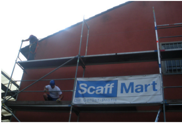
Abb 5: Gerüstmonteur gesichert mit PSA und HSG
