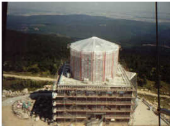
Brocken im Harz - runde Einhausung mit Schumpffolie und Ösenbandplane (Quelle. Rk-planen, Hamburg)
