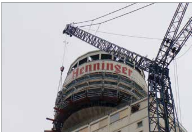
Foto: Gerüstbau Paul GmbH
